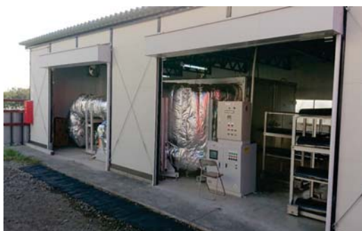
写真1 rCFの乾留設備(30 t/月)
